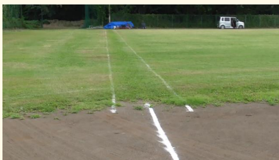
↑ 改修前、白線の中を整備します
